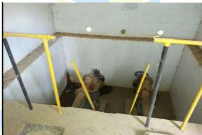
Figura 8 – Escada da casa de bomba da ETA sem guarda corpo e em péssimo estado de conservação.
