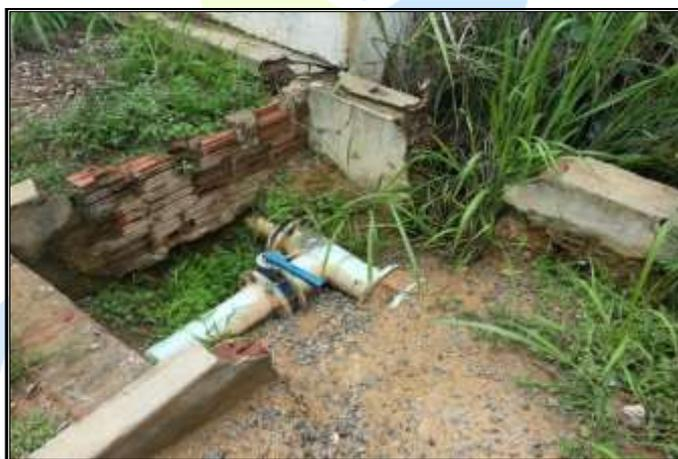
Figura 11 – Caixas de alvenaria desgastadas.
