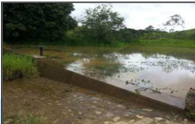
Figura 10 – Barragem da ETA com grande quantidade de vegetação e areia.
