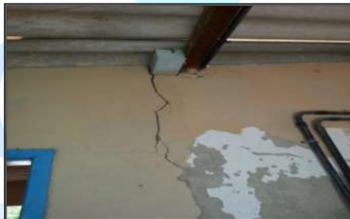
Figura 13- A trepidação da bomba provoca fissuras nas paredes da casa de química.
