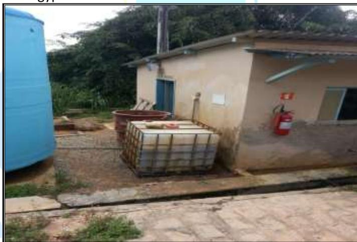
Figura 3 – Reservatório de sulfato de alumínio sem tampa.
