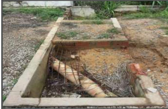
Figura 14- Grelhas deterioradas na ETA.
