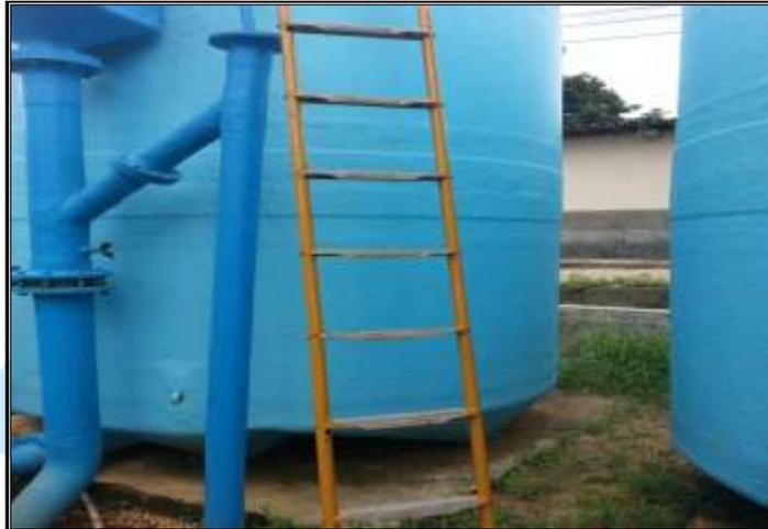
Figura 7 – Escada do filtro da ETA instável e sem guarda corpo.
