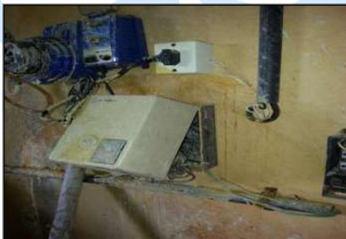
Figura 6- Ponto elétrico danificado e em desuso na casa de química.
