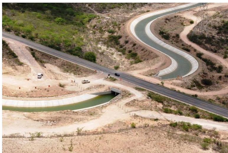
Figura 3 – Mosaico de trechos executados do Canal do Sertão Alagoano
