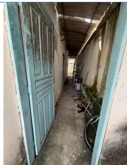
Foto 30 - Acesso área de serviço
