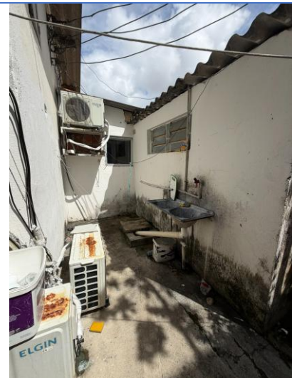
Foto 32 - Acesso área de serviço
