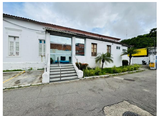
Foto 66 - Acesso às salas
