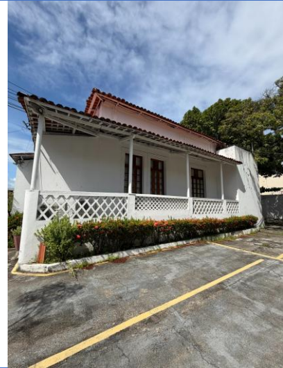
Foto 08 - Vista da fachada salas
