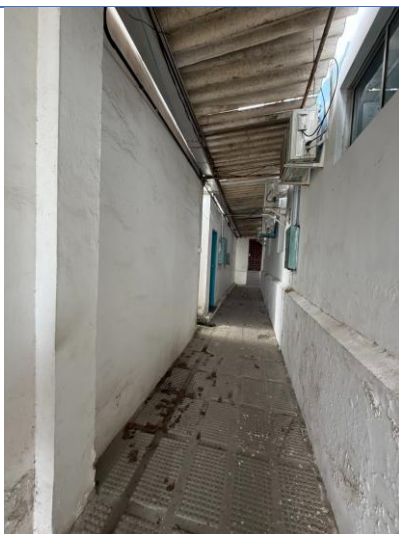
Foto 65 - Acesso às salas
