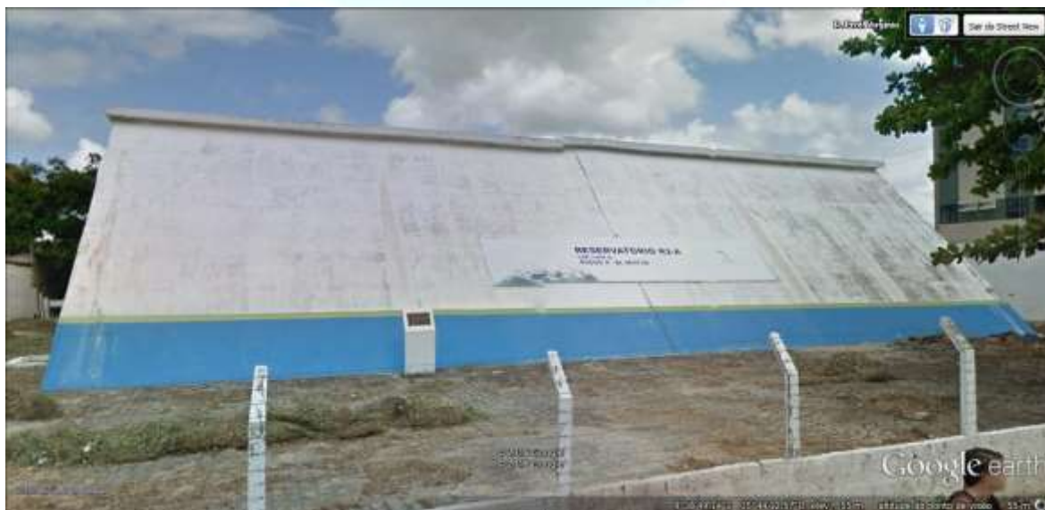
Figura 7. Vistas do reservatório apoiado R-02A
