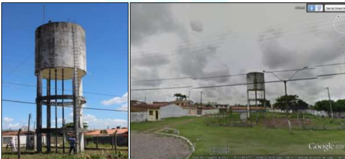
Figura 1. Reservatório do conjunto Henrique Equelman.
