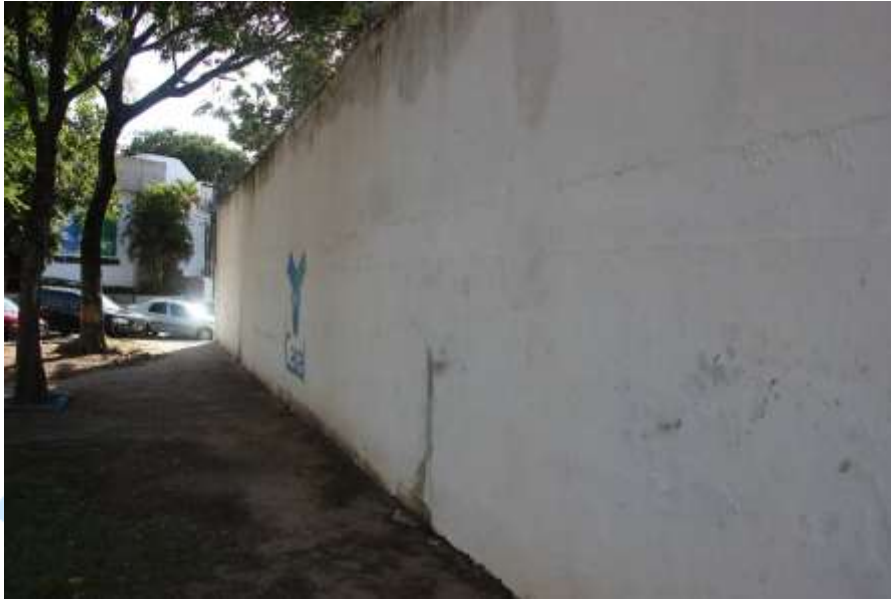
Figura 4. Vista da lateral e fundo do reservatório
