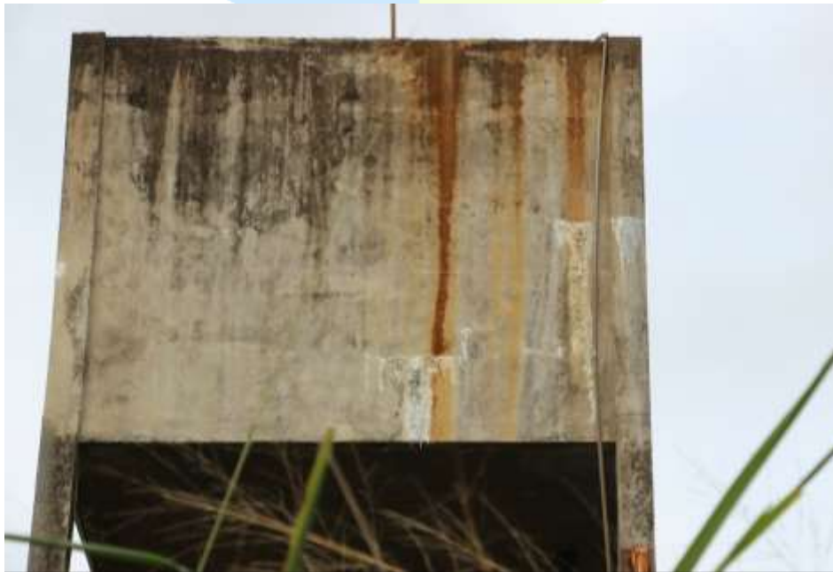
Figura 3. Parede do reservatório
