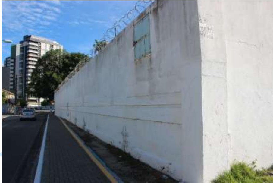
Figura 2. Vista lateral do reservatório
