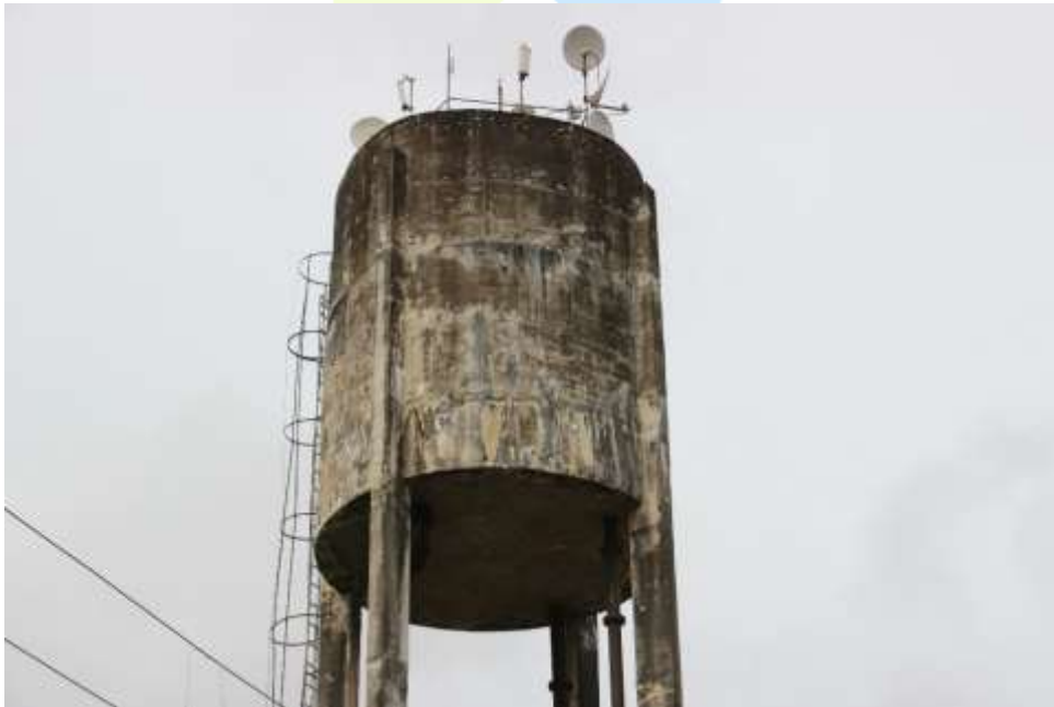
Figura 5. Parede do reservatório
