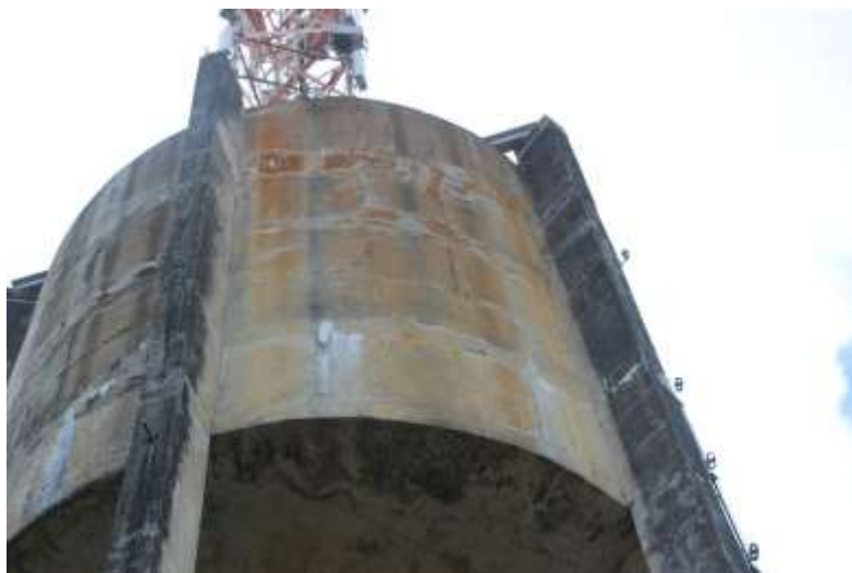
Figura 8. Vista da parede do reservatório
