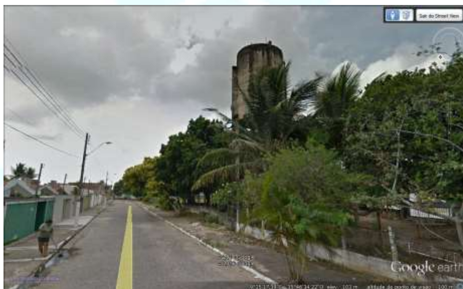
Figura 8. Vista do reservatório.
