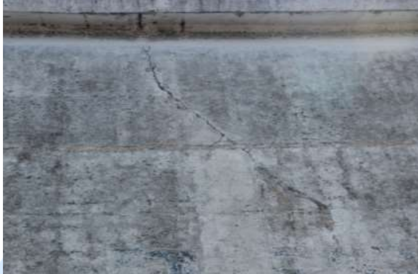
Figura 7. Fissuras na parede
