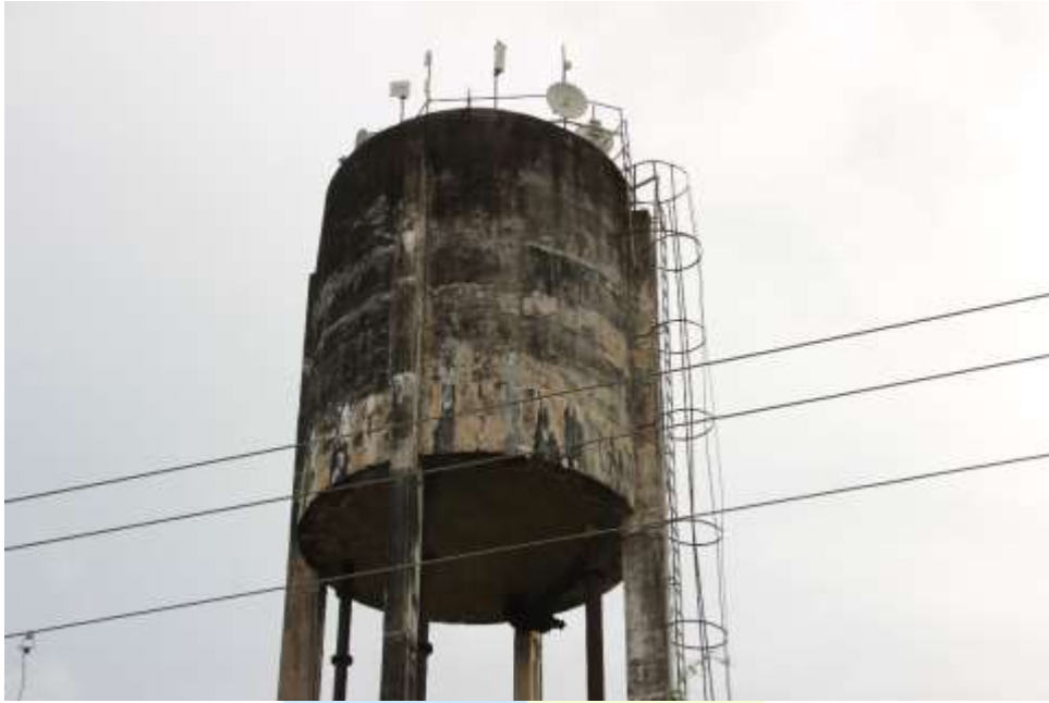
Figura 4. Vista do reservatório elevado
