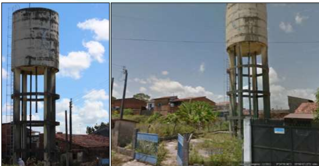
Figura 2. Reservatório do conjunto Durvillé.
