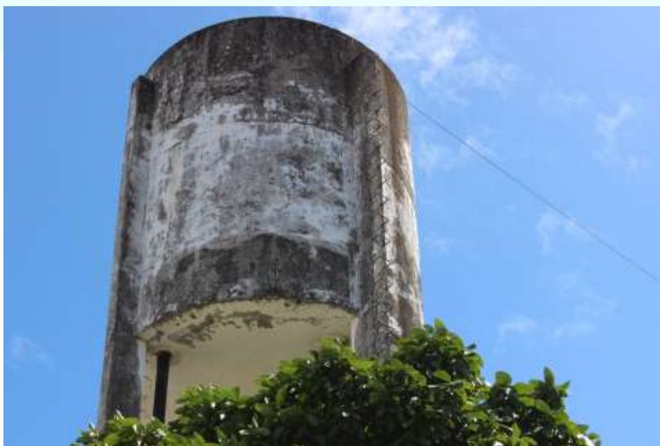
Figura 2. Vista do reservatório
