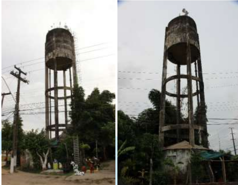
Figura 5. Vistas do reservatório do Residencial Terra de Antares.
