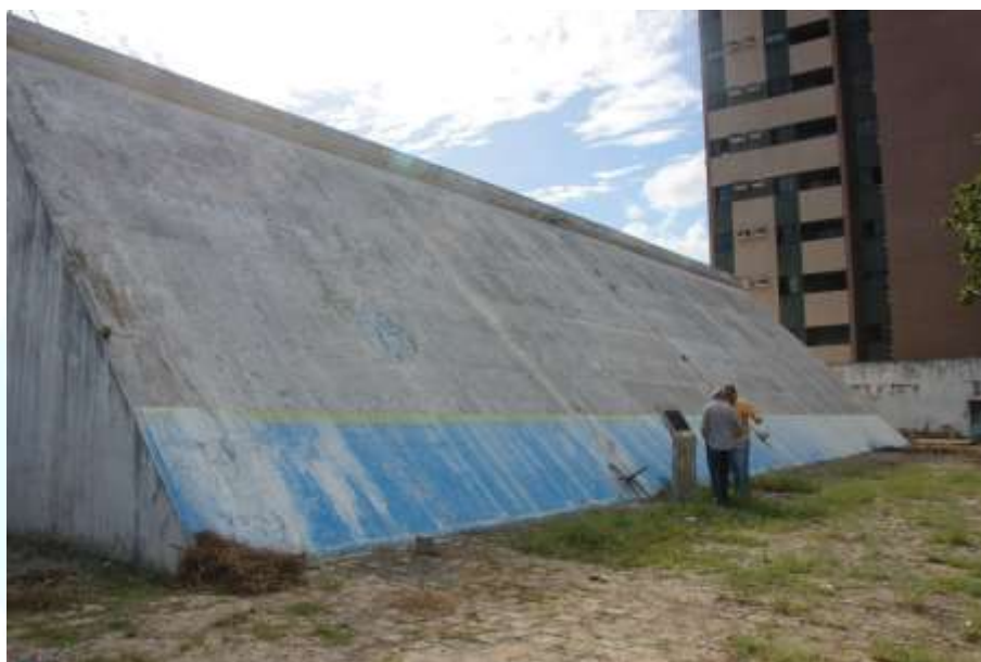
Figura 2. Vista do reservatório
