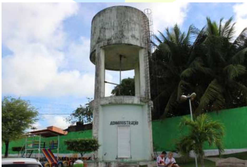
Figura 4. Reservatório do conjunto Morada Nova.
