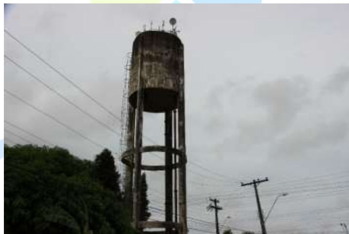
Figura 2. Vista do reservatório
