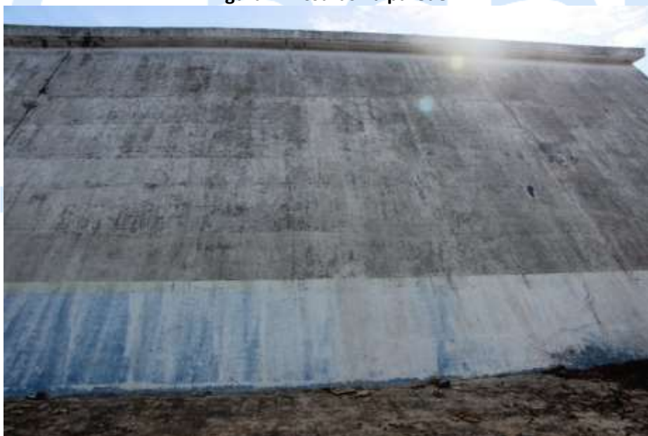
Figura 7. Fissuras na parede
