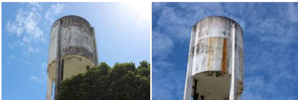
Figura 6. Vistas do reservatório do Conjunto Senador Rui Palmeira.
