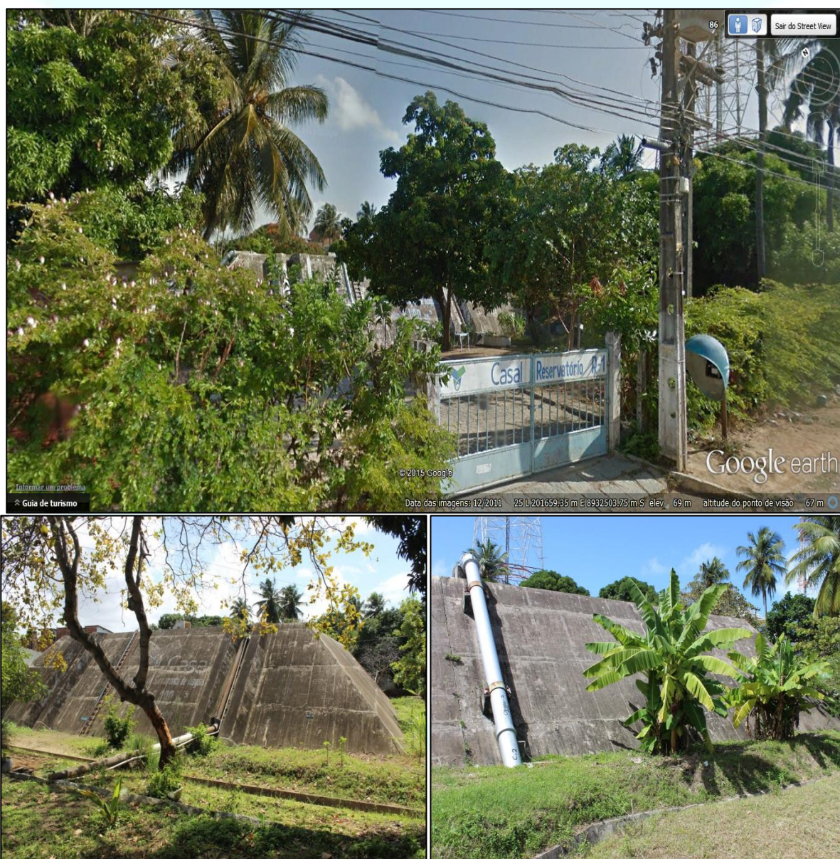
Figura 1. Reservatório R1 no bairro do Jacintinho.
