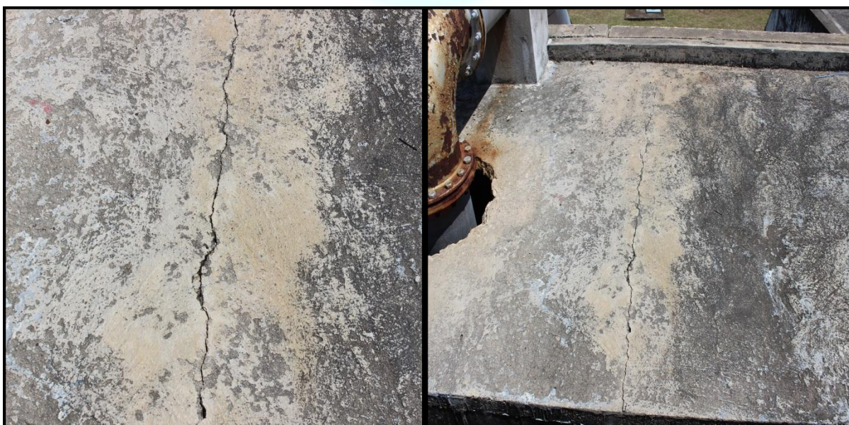
Figura 5. Corrosão da armadura com perda de seção na lajes
