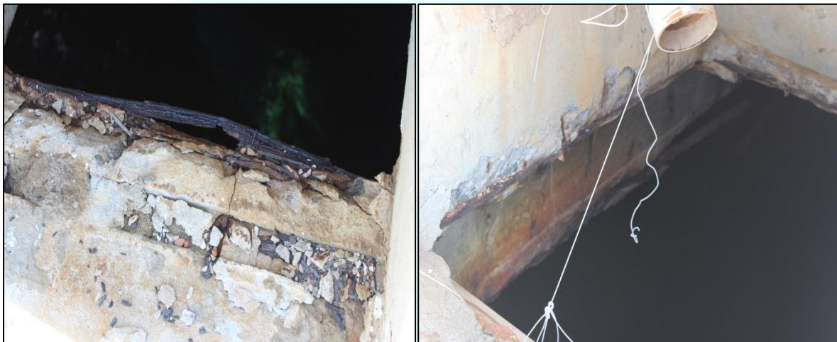
Figura 5. Corrosão da armadura com perda de seção na lajes
