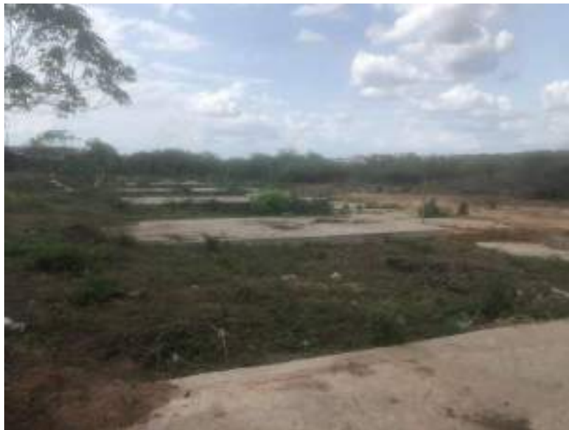
Figura 5 – ETE do setores 04 , 05 e 06
