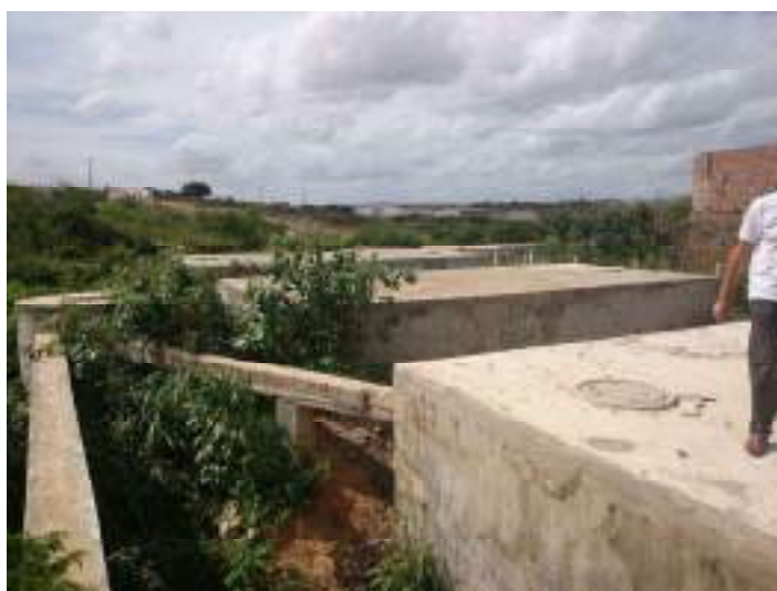
Figura 3 – ETE do setor 02
