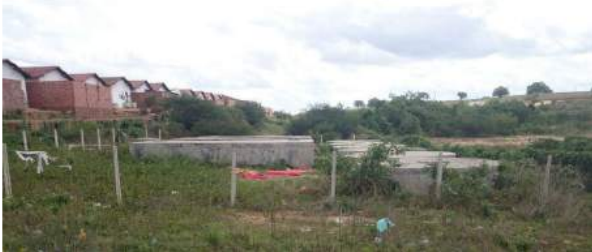
Figura 4 – ETE do setor 03
