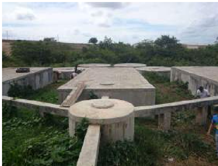
Figura 2 – ETE do setor 01
