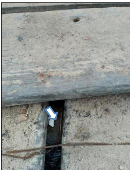
Figura 4. Uma das vigas principais em perfil “I”.
