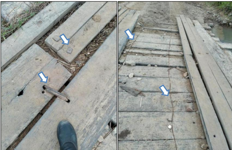
Figura 3. Detalhe dos grampos de fixação dos pranchões de madeira sobre as vigas metálicas (longarinas) (A) e fixação das transversinas (B).
