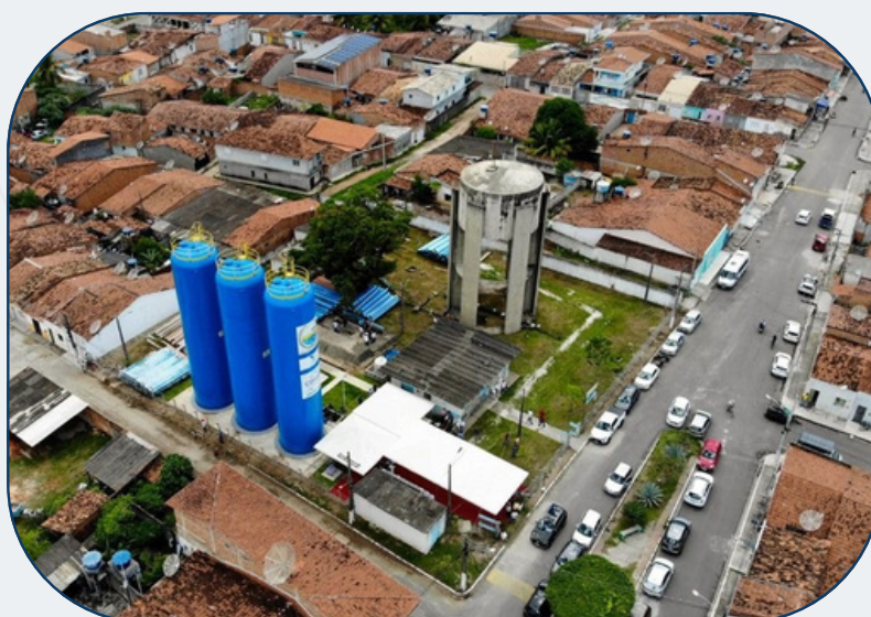
Sistema de Reserva de Água Bruta Piaçabuçu
